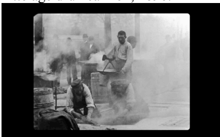
Ouvriers réparant un trottoir en bitume, 1898.
